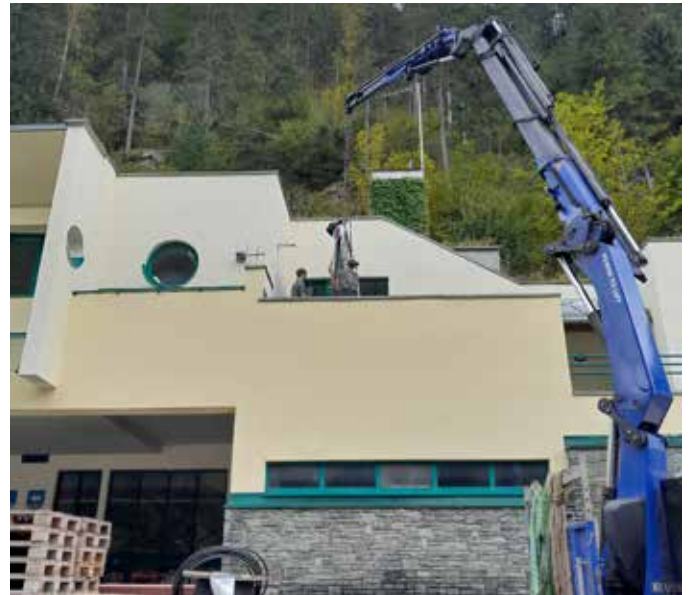
Bild: Die Kläranlage Hinterstoder ist seit genau 30 Jahren in Betrieb
